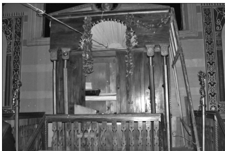
В разрушенной синагоге
